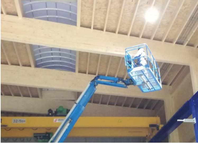
Die Deckenleuchten werden mithilfe eines Steigers montiert – hier ist höchste Aufmerksamkeit erforderlich.
