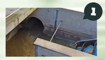
Über den Zulauf gelangt das Abwasser in die Kläranlage. Dort befinden sich Schneckenpumpen, welche das Abwasser auf das Niveau der Anlage heben, damit es dann die restlichen Stationen der Kläranlage durchlaufen kann. Je nach ankommender Abwassermenge sind bis zu vier Pumpen gleichzeitig in Betrieb
