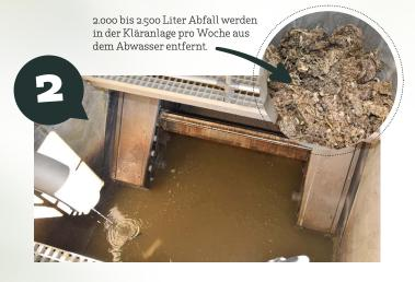
Der erste Schritt des Aufbereitungsprozesses ist die Entfernung von Feststoffen, die eigentlich nicht in das Abwasser gehören. Dazu läuft das Abwasser über ein Sieb mit 4 mm Spaltbreite. Zurück bleibt eine beträchtliche Menge an Müll, der als Restmüll entsorgt werden muss.
