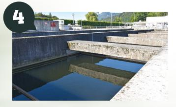
In der letzten Station des Abwassers lagert sich der Schlamm inklusive der Bakterien am Boden ab. Dieser Klärschlamm wird dann zum Teil wieder zurück in das Belebungsbecken gepumpt, um dort erneut zu "arbeiten". Das gereinigte Abwasser läuft im Anschluss, nach entsprechender Analyse, in den Inn.
