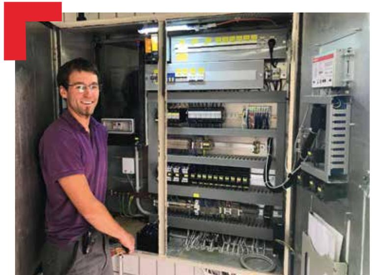
David Naschberger bei der Installation der neuen Steuerung für die digitale Wasserüberwachung in Rettenschöss.
